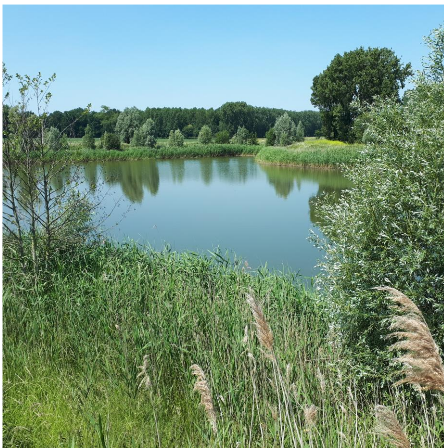
Photo q: Le bassin d'inondation contrôlée sur le Grote Kimmelbeek doit préserver les maison alentour des inondations; en outre, le bassin de retenue peut répondre à la demande d'eau aux cours des périodes de sécheresse.
