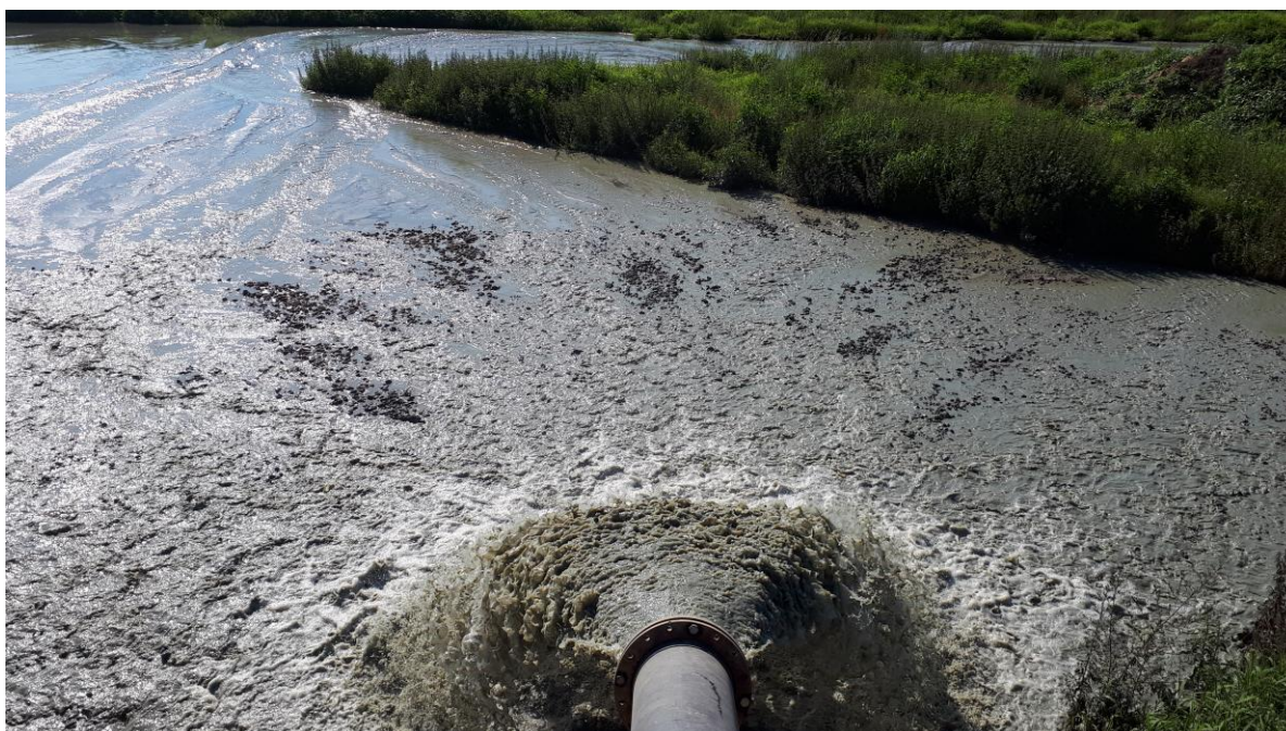
Photo h : Entrée du bassin de traitement des boues
