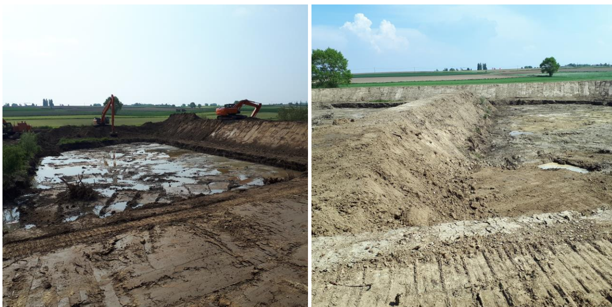
Photo g : Il est équipé d'une berme centrale pour prévenir davantage la sédimentation (en ralentissant le débit de l'eau)
