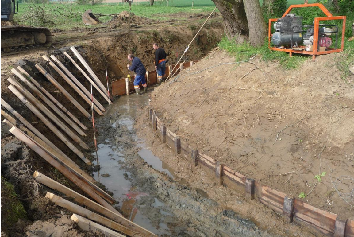
Photo b : Placement de poteaux en chêne et de cloisons en bois dur pour protéger la pointe du cours d'eau
