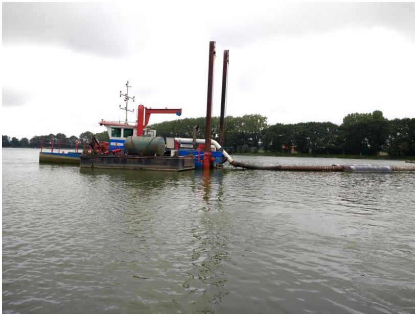
Photo 1 : Par un mouvement de balayage, la drague nettoie le fond de l'Étang de Dikkebus de ses boues.
