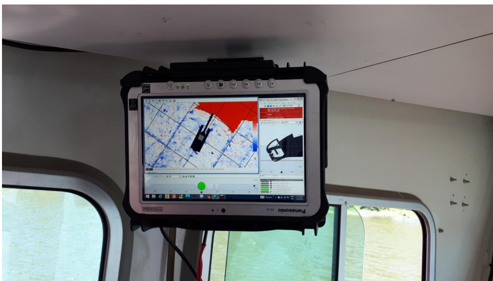
Photo n : Le batelier peut suivre l'avancement des travaux sur un écran d'ordinateur monté dans la cabine de la drague.
