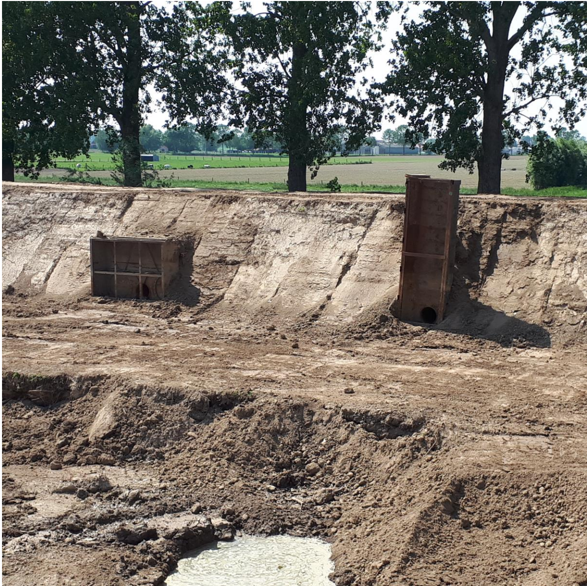
Photo i : Des caissons inondés permettent de réguler le débit (et par conséquent le taux de sédimentation).
