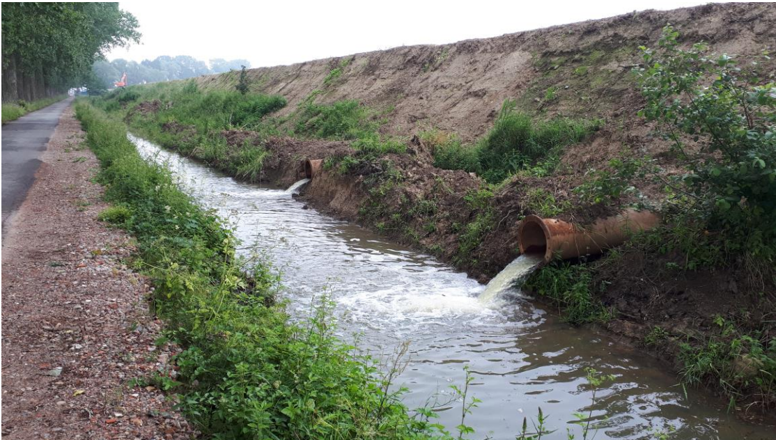
Photo j : Exutoire du bassin de traitement des boues
