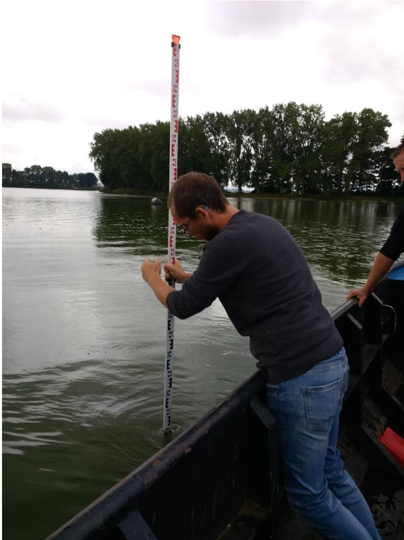
Photo k : Au cours des travaux l'administration commanditaire (la ville d'Ypres, la Province de Flandre occidentale et de Watergroep) contrôle régulièrement les travaux de dragage effectués.
