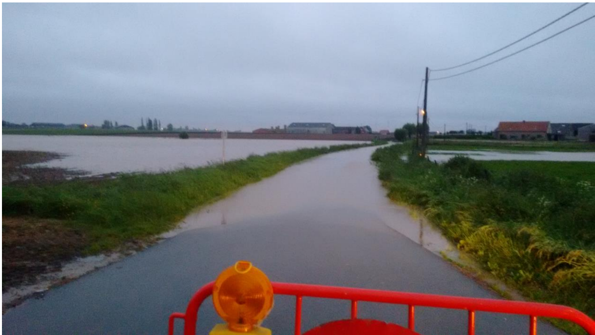
Photo s: En rehaussant la chaussée dans la Grote Branderstraat et en plaçant un limiteur de débit, la zone de rétention naturelle en amont de la vallée du Grote Kemmelbeek peut être agrandie.
