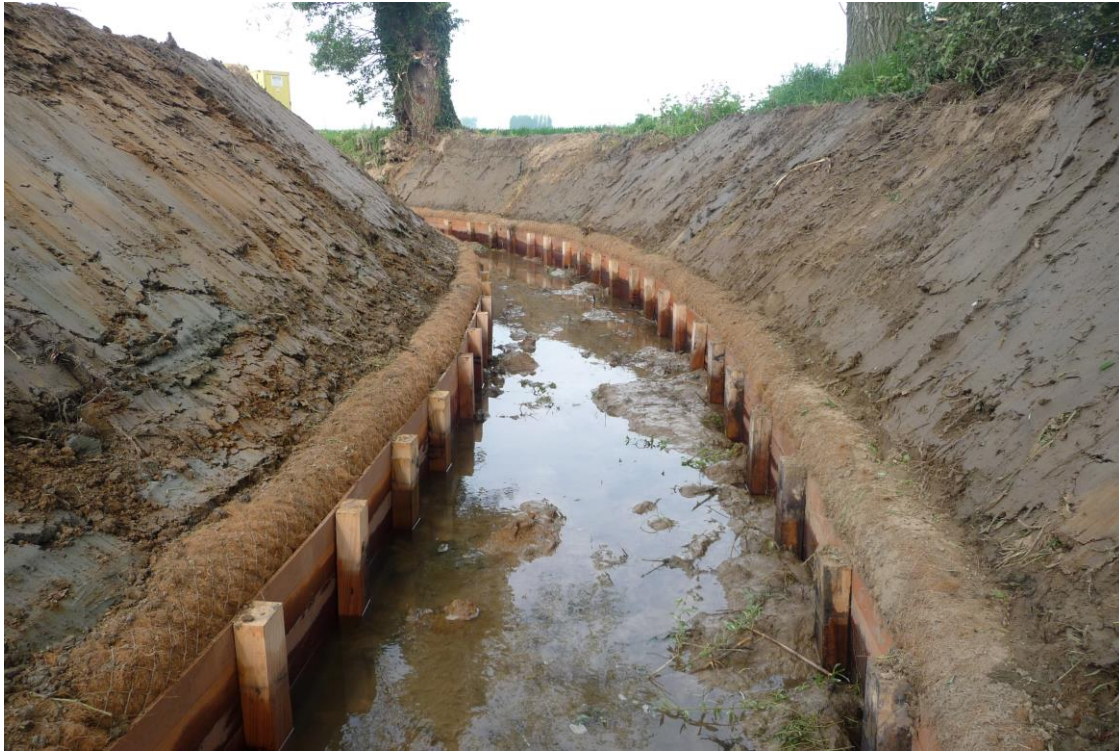
Photo c : Le placement de rouleaux en fibres de noix de coco facilite le développement spontané de la végétation à proximité de la ligne de crue.
