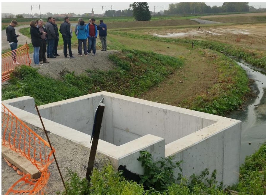
Figure 1 - Visite bassin d'orage Blandain
