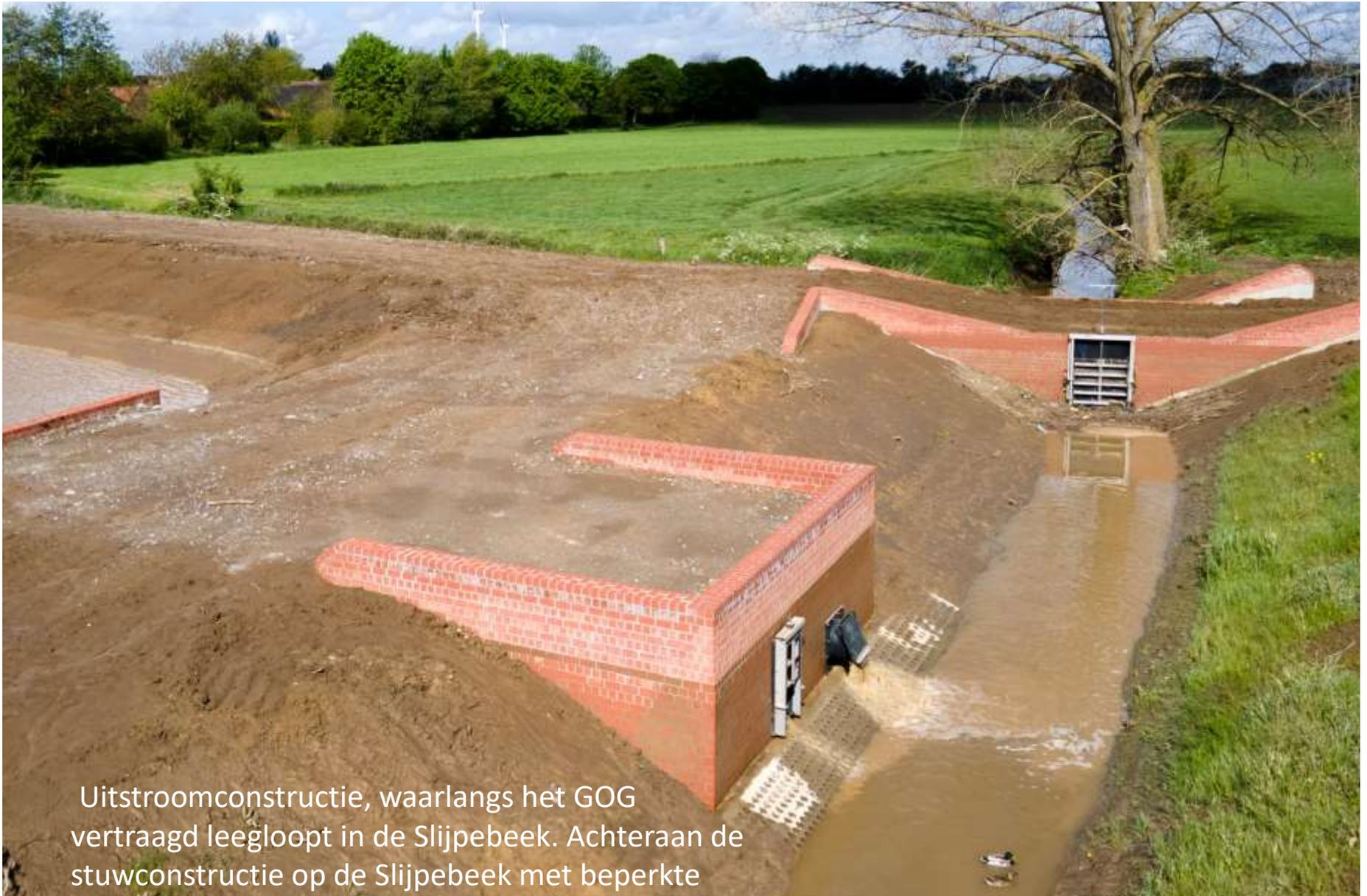
Uitstroomconstructie, waarlangs het GOG vertraagd leegloopt in de Slijpebeek. Achteraan de stuwconstructie op de Slijpebeek met beperkte
